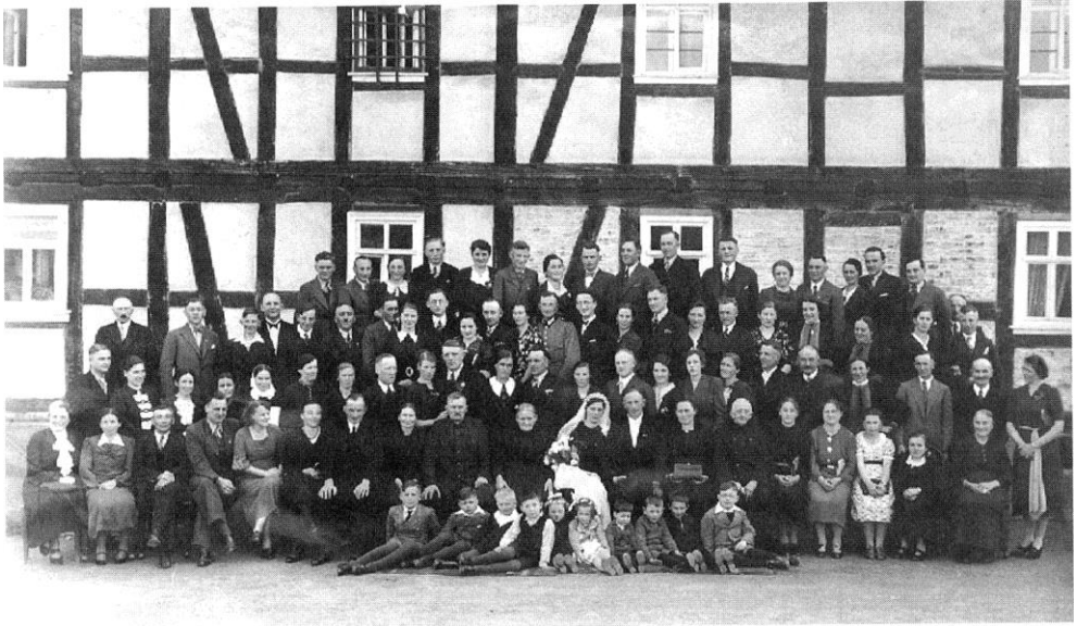
Die Straßenfront des Hauses Prenntzell (Kleinmoor Nr. 1 - Stoffels), früher Hämmelmann, heute Broser mit der Hochzeitsgesellschaft des Brautpaares Gustav Rübenstahl aus Gruben und Katharine geb. Prenntzell im Jahre 1939. Das Haus wurde 1841 erbaut.
