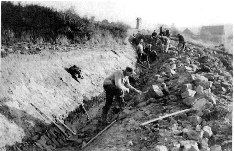
Die Bauarbeiten am Hauptflutgraben und am Feldweg oberhalb des Dorfes im Zuge der Flurbereinigung.
