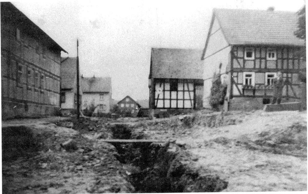
Straßen- und Kanalbau in den 60er Jahren.
