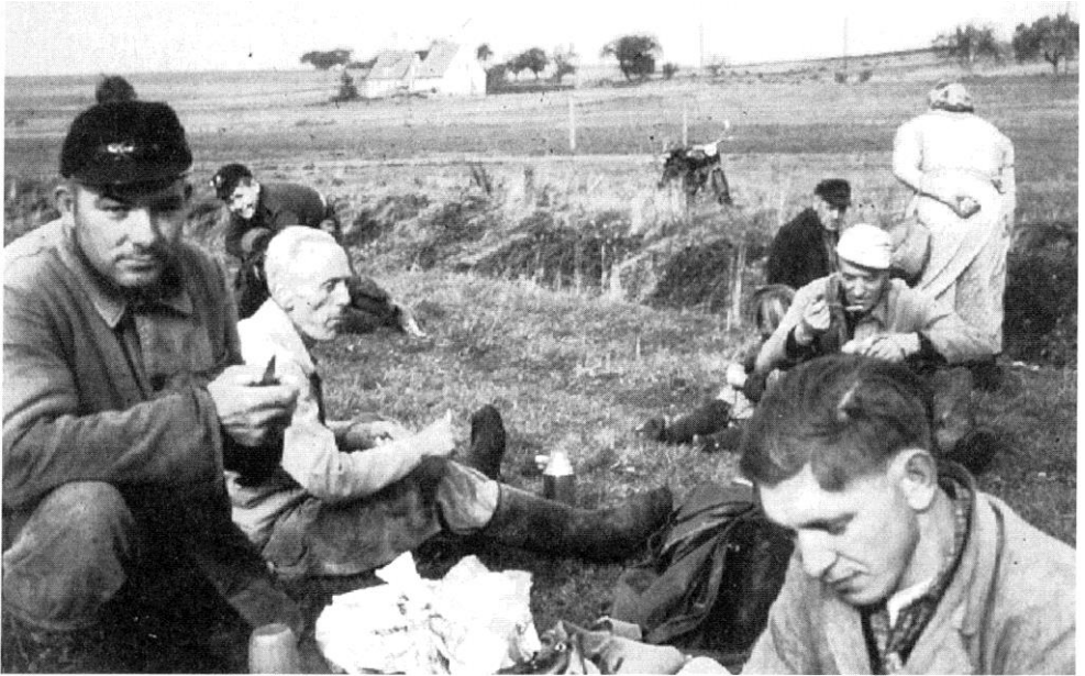
Während der Flurbereinigung in Schlotzau (1955/57) wurde der Weihergraben auf etwa 1000 m Länge mit Betonschalen ausgelegt. Jede Schale hat eine Grundfläche von 1 qm, wiegt 6-7 Zentner und hat 17,85 DM gekostet. Von links Fischer, Michael Meier, Max Denk, Anna Denk.
