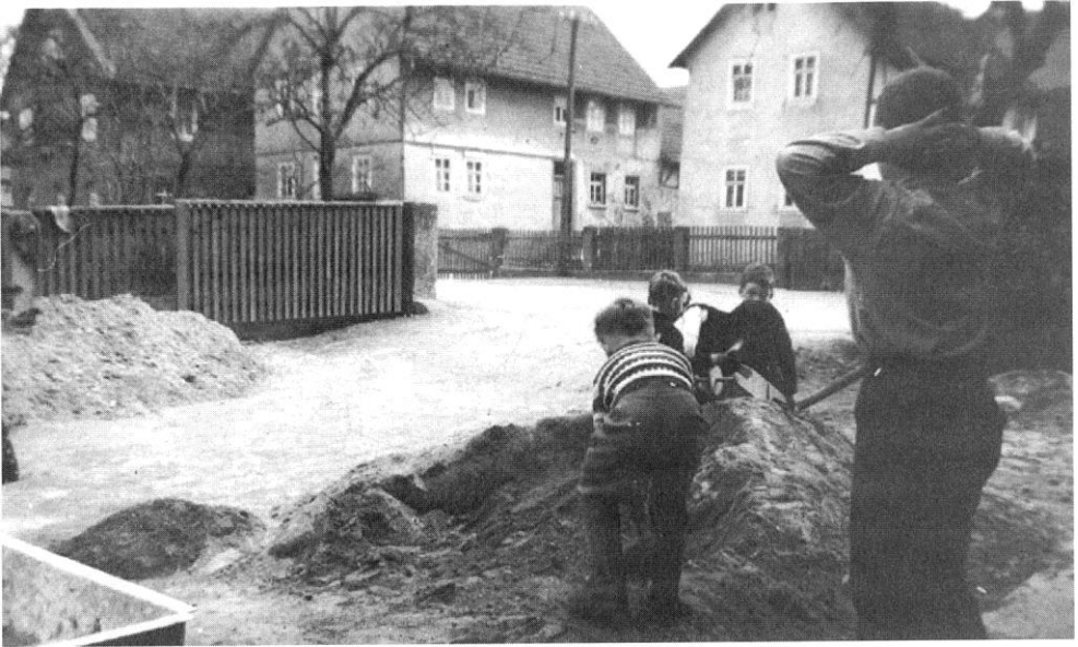
Haus Schafer I (Nr. 16 - Engels) in der Mitte; es wurde vor 1908 von der Familie Schafer (Schafersch) bewohnt; es trägt auf einem Stein die Inschrift: "Mit Gottes Hilfe had erbaut dieses Haus H. Schafer u. tss Ef: Kngd: (Kunigunde) Kranz M. M. 213 (= ) 1878". Rechts daneben sehen wir Haus Kemmler (Nr. 16 1/2 - Streak), früher Schafer, heute Stuckardt. Die Kinder sind von links: Helmut Ruppel, Harald Hochhaus, ???, Jürgen Hochhaus, ???. Die Aufnahme ist im Jahr 1962.
