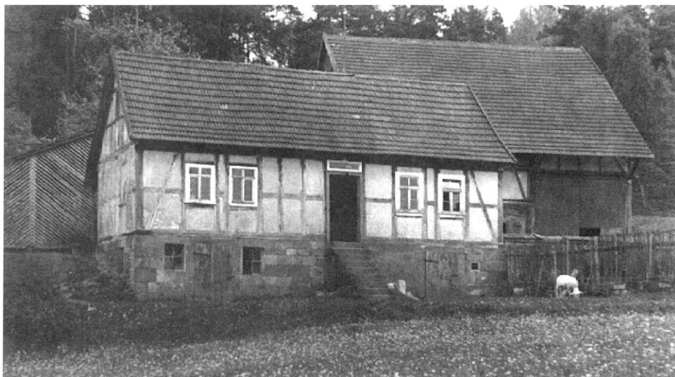
Oben: Haus Quanz (Kiefersch), abgerissen 1945.
