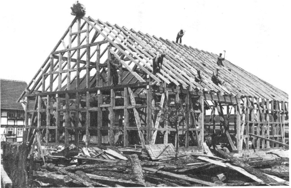
Zimmerei Pflanz stellt ausschließlich in Handarbeit eine Scheune auf 1920.
