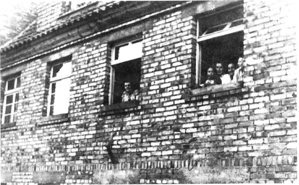
Wohnhaus Schmidt, "Poste", Am Dorfborn 1.
