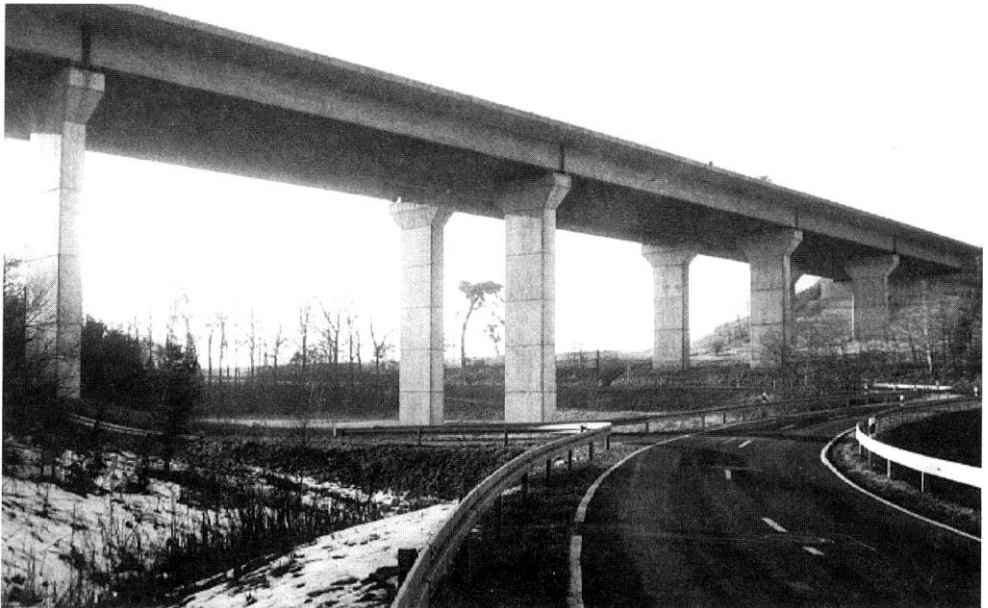
Oben: Talbrücke Langenschwarz, an der Wehrdaer Straße 326 Meter lang 27 Meter hoch 21 Monate Bauzeit 4,1 Mio. DM Baukosten
