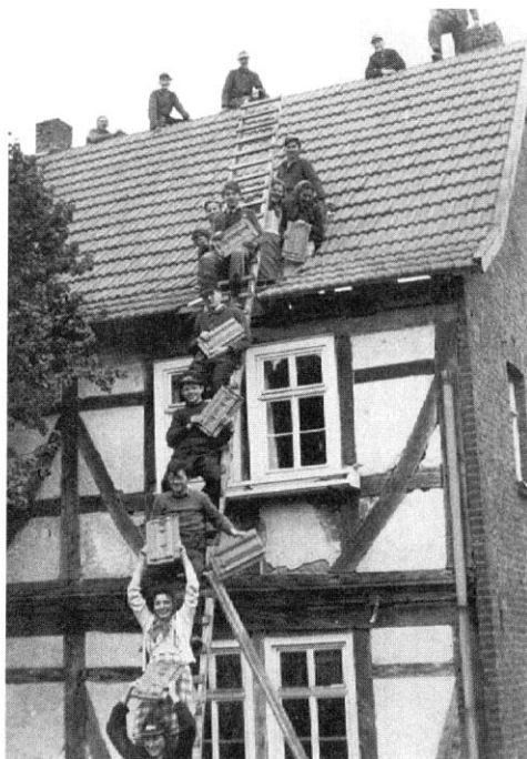
1958, die Schwesternstation wird neu eingedeckt
