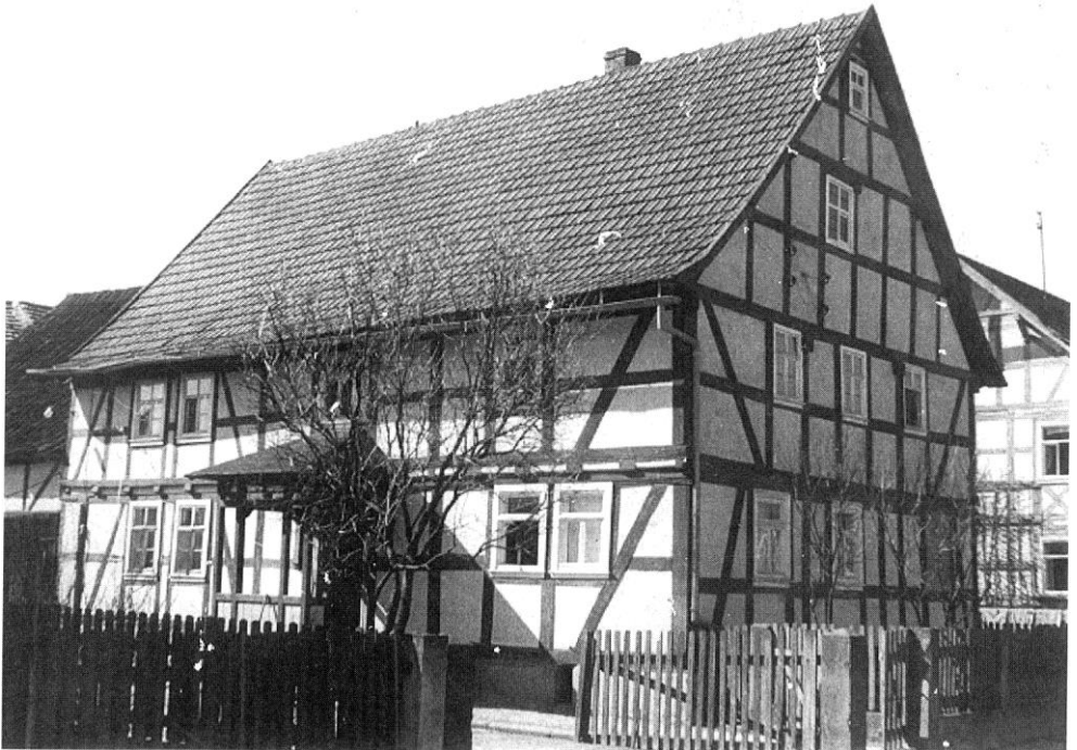
Haus Eydt (Nr. 17 - Phillipse), früher Laudenbach, um 1940. Das Haus wurde im Jahr 1686 erbaut.
