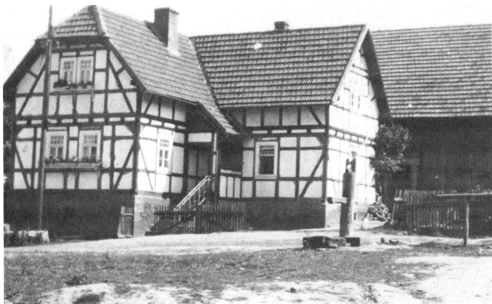
Haus Eigenbrod (Koche), erbaut 1909.
