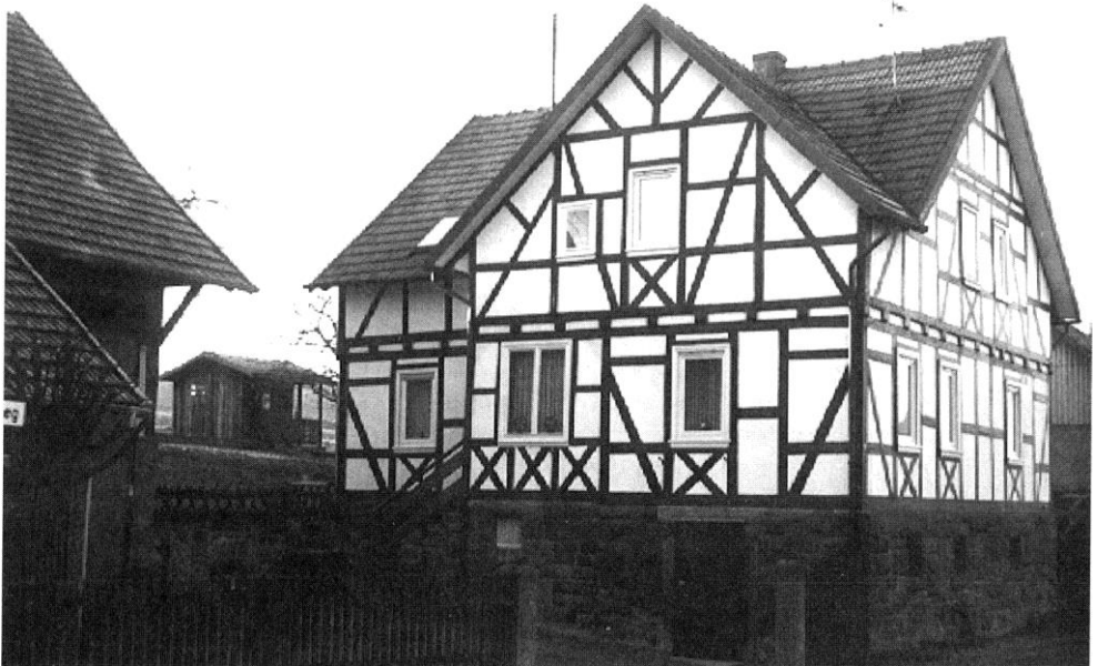
Wohnhaus Hofmann, "Raose", Schloßweg 6. 1913 wurde das Wohnhaus von Wilhelm Hofmann, Maurer, gebaut. Die Westseite des Wohnhauses ist mit Schindeln gedeckt, die in den 30er Jahren vom jetzigen Eigentümer Andreas Hofmann angebracht wurden.
