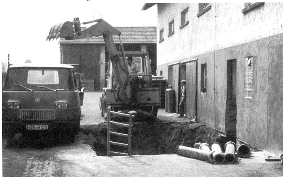
1982 - Einbau der Fuhrwerkswaage..
