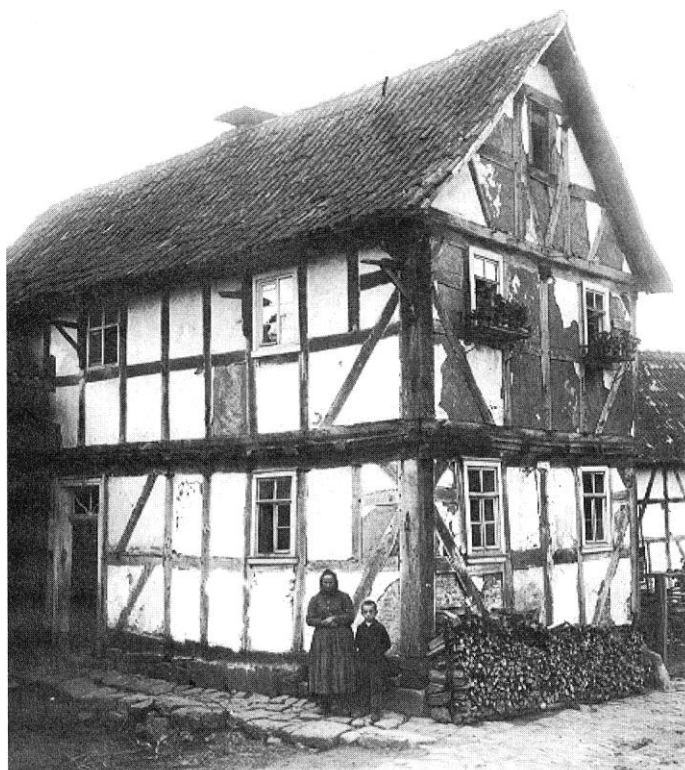
Wohnhaus Kemmler, "Kemmlesch", Kirchberg 7. Zu den ältesten, noch stehenden Wohnhäusern in Langenschwarz zählt das Haus Kemmler, Am Kirchberg, dessen Erbauungszeit in der Mitte des 17. Jahrhunderts lag. Das Wohnhaus wurde vom jetzigen Eigentümer Christian Kemmler 1950 restauriert, 1990 ausgebaut. Auf dem Bild ist Frau Lisette Kemmler, geb. Fischer mit Sohn Karl.
