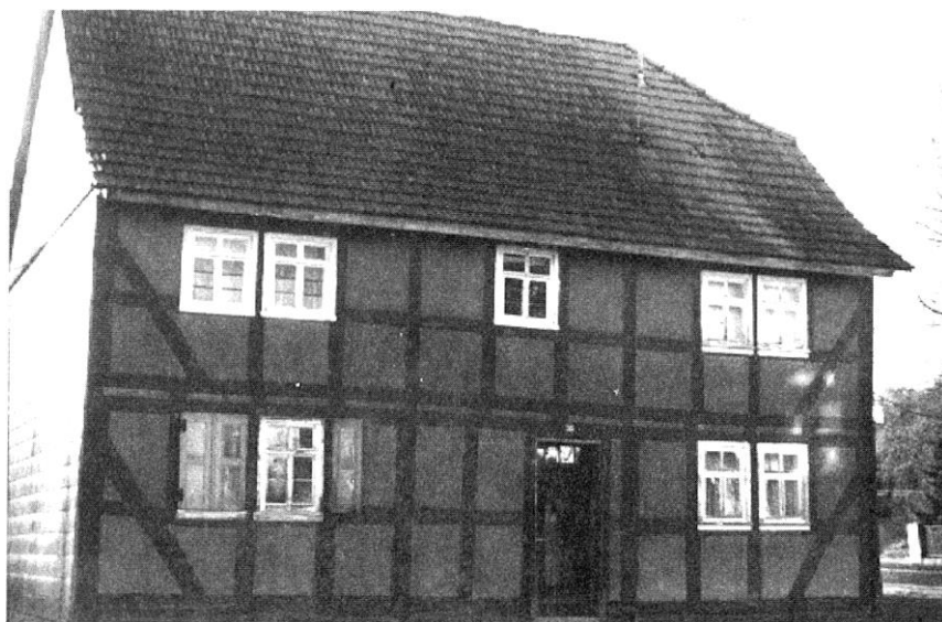
Wohnhaus Bolender, "Wilhems", Hauptstraße 23. In diesem Haus war einst das Amtsgericht von Langenschwarz untergebracht. Jetzige Eigentümerin ist Lisette Bolender.
