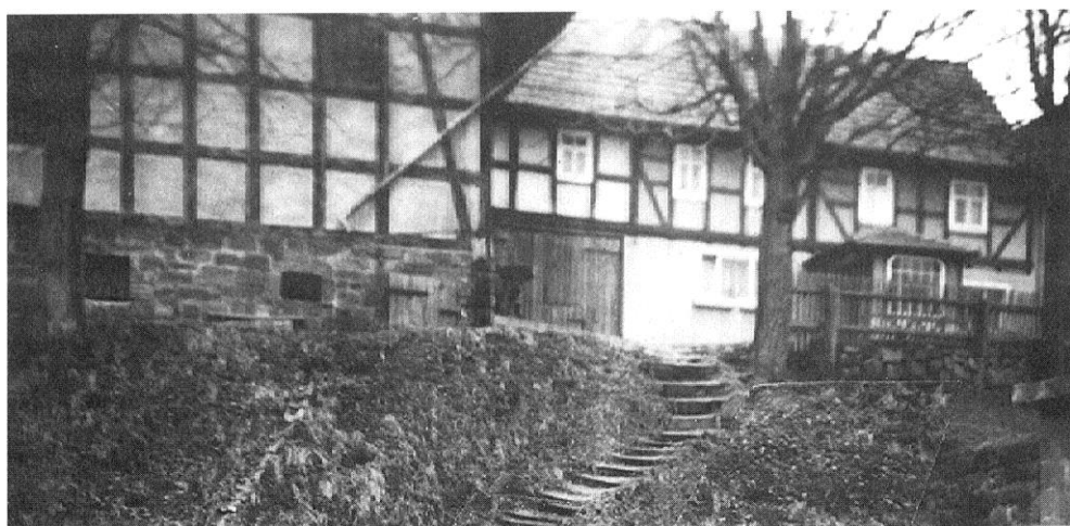
Anwesen Hildebrand, "Hellebrahns", Dorfblick 3. Das Wohnhaus wurde bereits 1929 erneuert, Stall und Scheune 1930 neu aufgebaut. Helmut Hildebrand hat 1969 das Wohnhaus abgerissen und neu aufgebaut.
